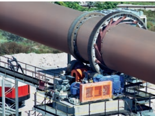
Flender-Zahnradgetriebe als Antrieb einer Rohrmühle: Bewährtes Einsatzfeld für die hoch belastbaren INA- und FAG-Wälzlager (Foto: Flender)
